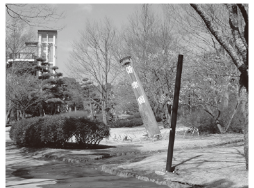
偕楽園・梅桜橋付近地盤沈下による木柱看板の傾き
